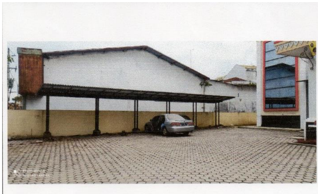
Gambar 3.4 Pembangunan Tempat Parkir dan Perbaikan Pagar Kantor Kecamatan Parakan
