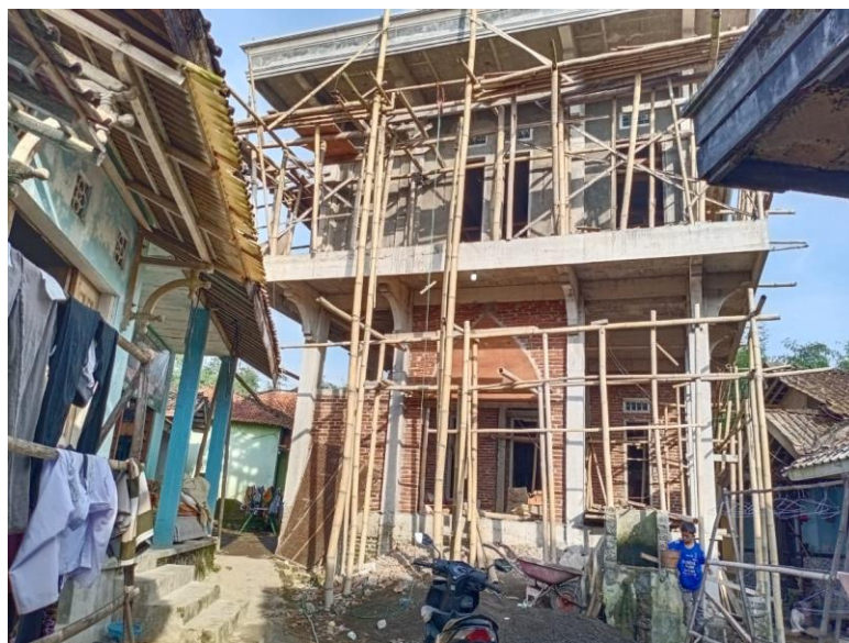
Gambar 3.6 Monitoring Pembangunan Masjid
